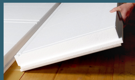
Die Isolationselemente können direkt in die Deckenschalung eingelegt werden.
