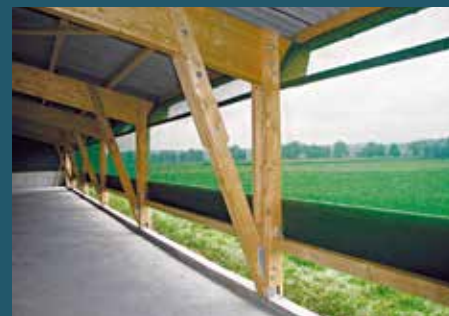
Windschutznetz in Geflügelauslauf
