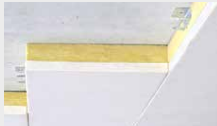
Verdeckte Montage mit Haltekrallen
