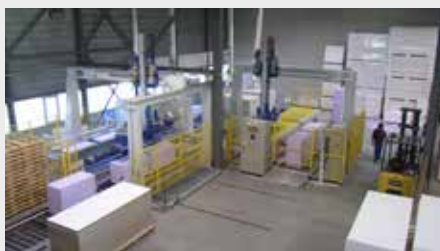
Produktionsanlage in Kägiswil
