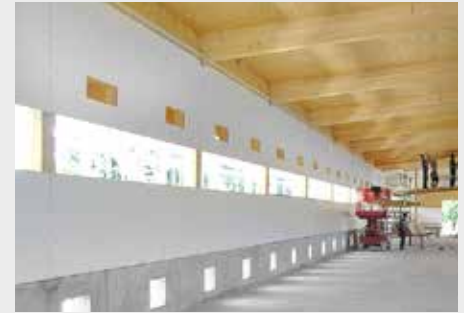
Wandverkleidung in landwirtschaftlichem Betriebsgebäude
