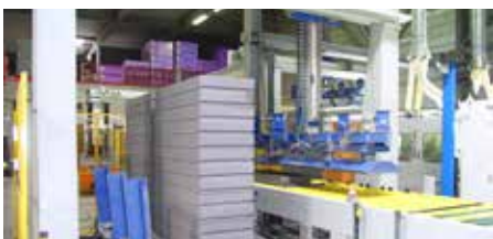
Produktionsanlage in Kägiswil
